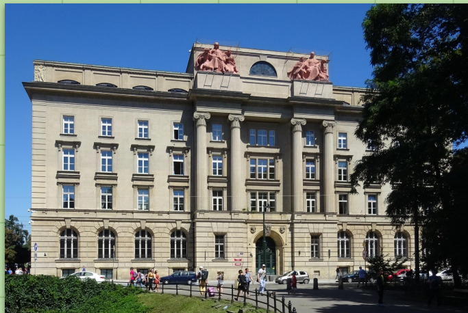
Gmach NBP w Krakowie ul. Basztowa 20
